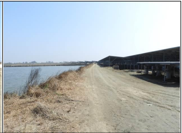
周邊環境現況-1號樣線
