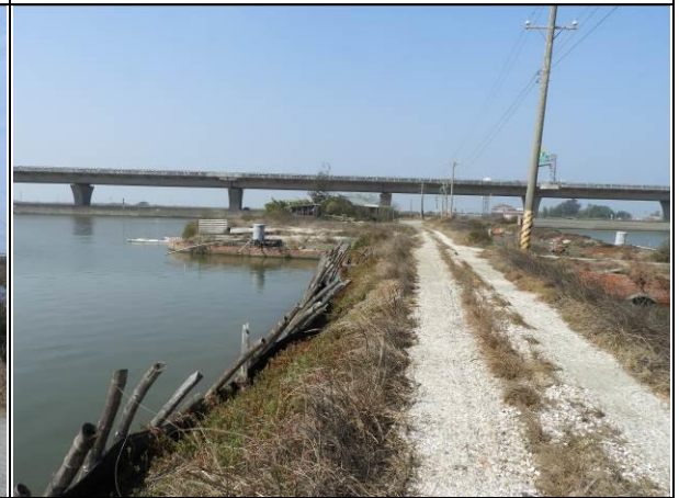
周邊環境現況-對照樣線
