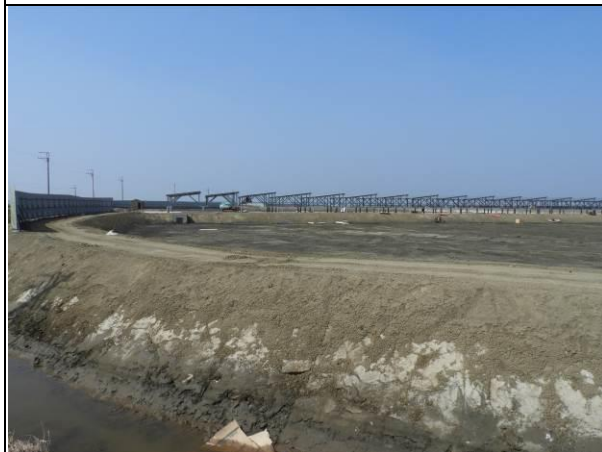
周邊環境現況-1號樣線
