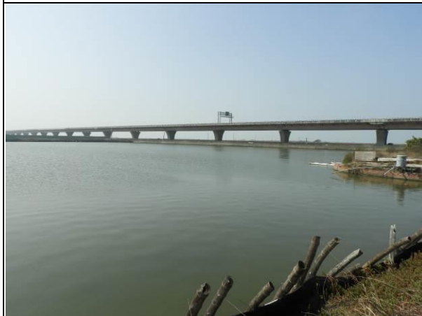
周邊環境現況-對照樣線
