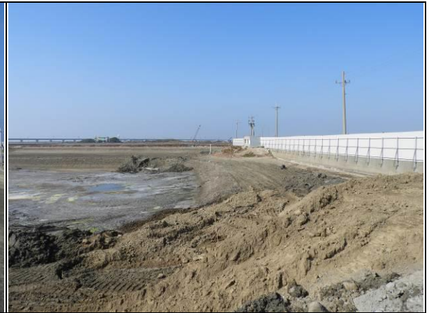
周邊環境現況-2號樣線
