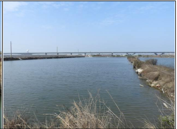
周邊環境現況-對照樣線
