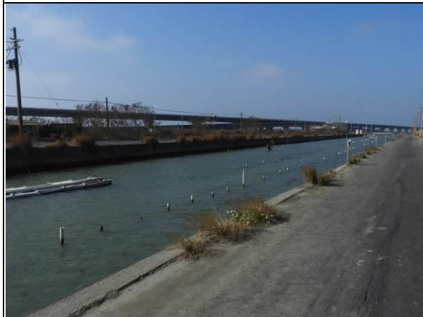
周邊環境現況-2號樣線
