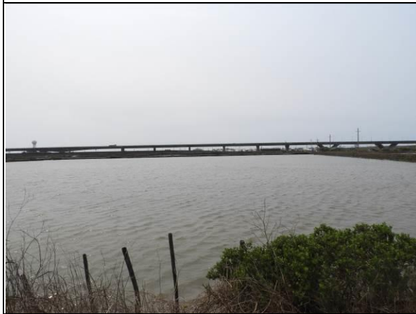
周邊環境現況-對照樣線
