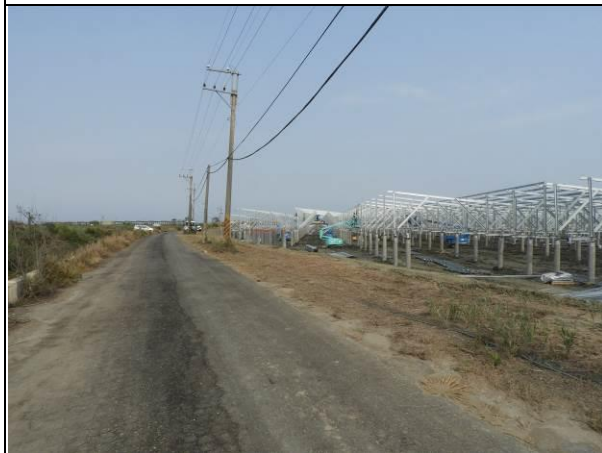
周邊環境現況-1號樣線
