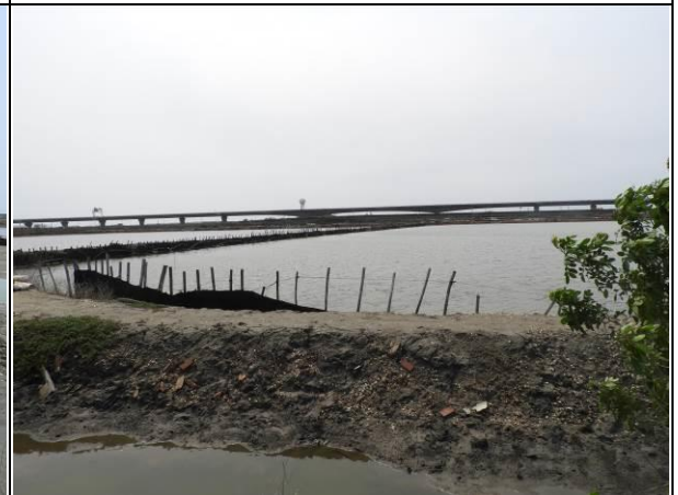
周邊環境現況-對照樣線
