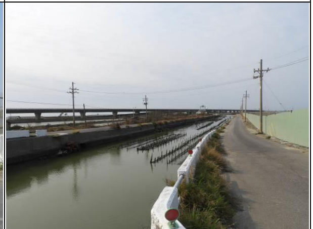
周邊環境現況-2號樣線
