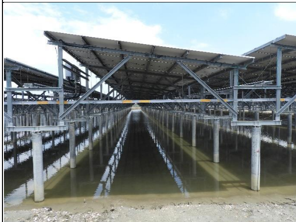
周邊環境現況-1號樣線
