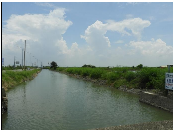
周邊環境現況-對照樣線
