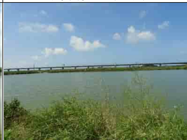
周邊環境現況-對照樣線
