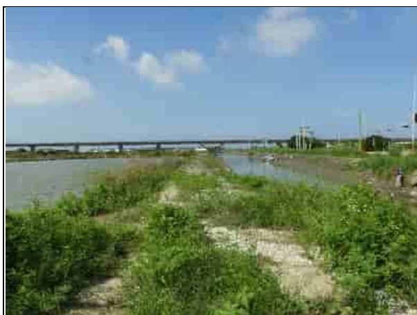
周邊環境現況-對照樣線
