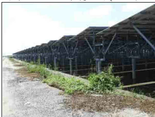
周邊環境現況-1號樣線
