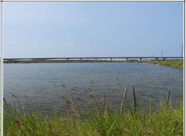
周邊環境現況-對照樣線
