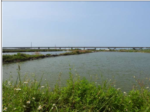
周邊環境現況-對照樣線
