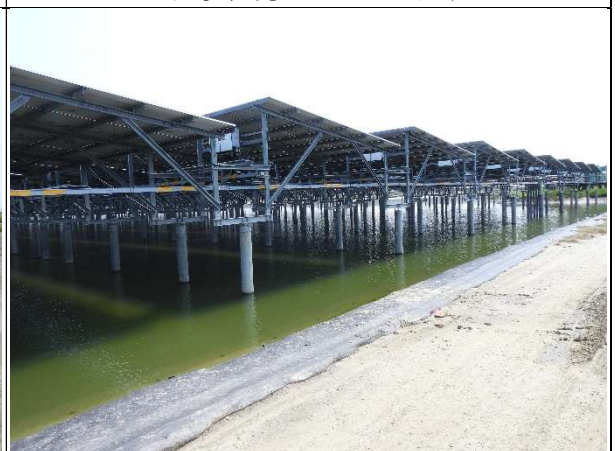
周邊環境現況-1號樣線
