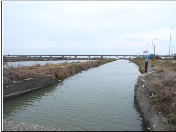
周邊環境現況-對照樣線
