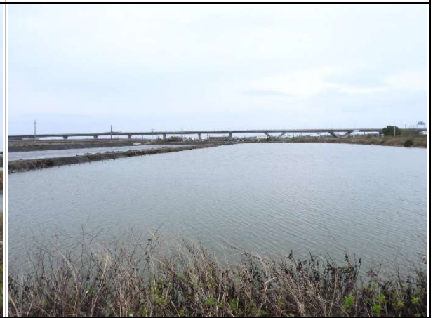
周邊環境現況-對照樣線
