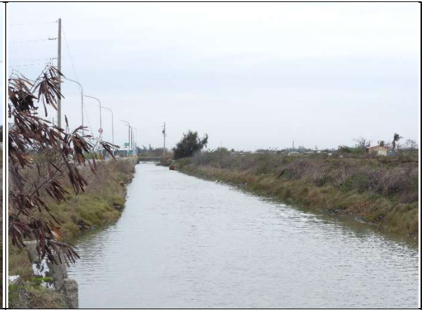
周邊環境現況-對照樣線
