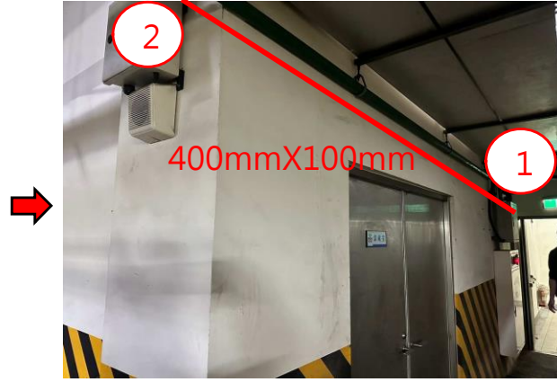
地下室管道間線槽走向
