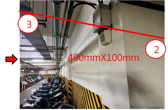
線槽延伸至機車道中間
