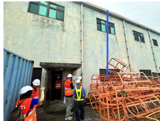
走線方式(線槽沿牆面由窗戶進去機電室)
