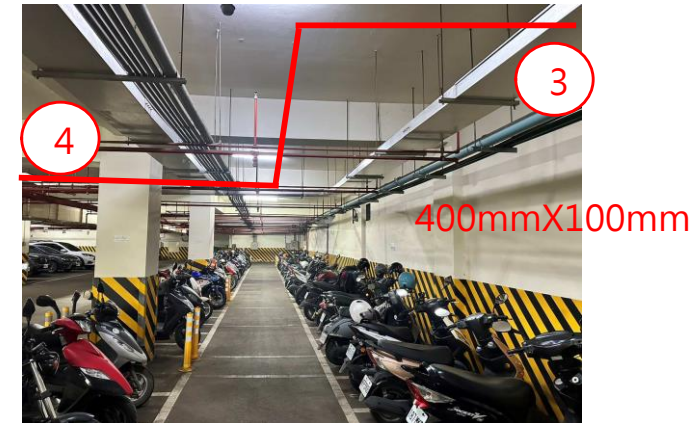
線槽由機車道中間左轉
